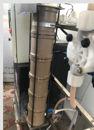
Sistema Gerador de Cloro - Marca: DIFILTRO, Modelo: CLT-36
