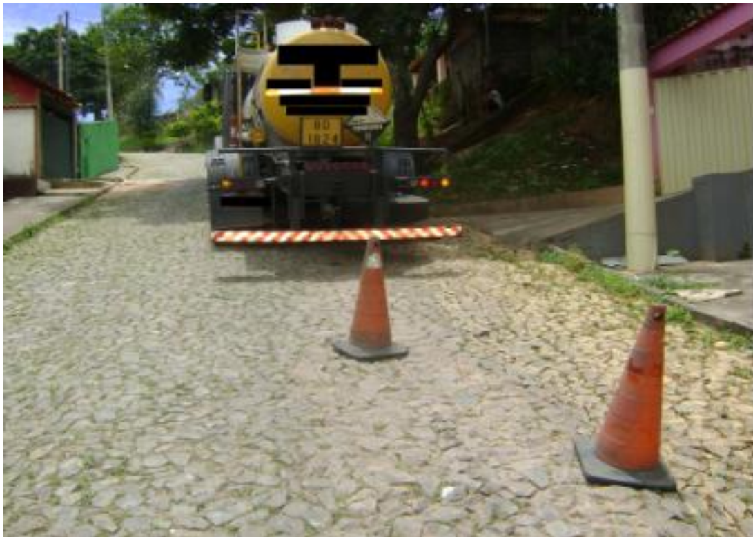
Foto 02: Subida íngreme sem calçamento asfáltico
